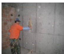
（图一）基层墙面清理
