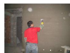
（图八）面层第二遍抹灰
