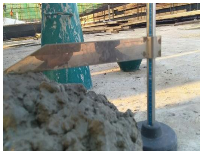
混凝土塌落度检查
