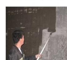
（图六）砖墙面涂刷界面剂
