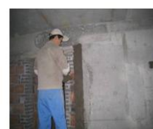
（图三）不同墙体材料基层补平
