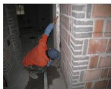
（图二）按规方线户型图贴灰饼
