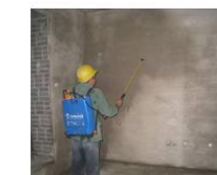
（图九）抹灰后喷水养护
