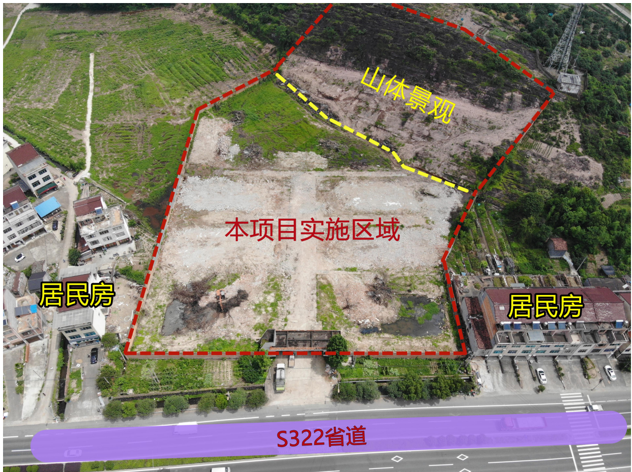
拟建场地全貌航拍图
