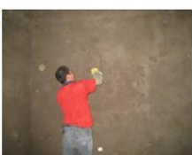
（图七）基层第一遍抹灰
