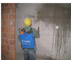
（图五）墙面提前一天喷水湿润
