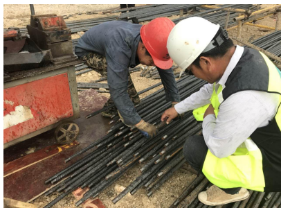
现场检查钢筋加工质量
